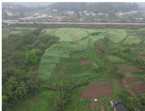
K39+300 左侧渣场现状
