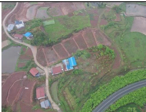
悦来互通 AK0+500 右侧 1#取土场现状
