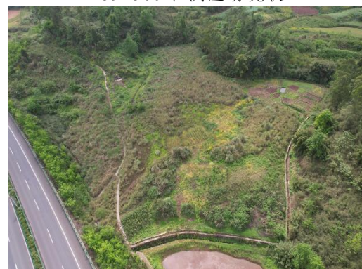
K67+300 右侧渣场现状
