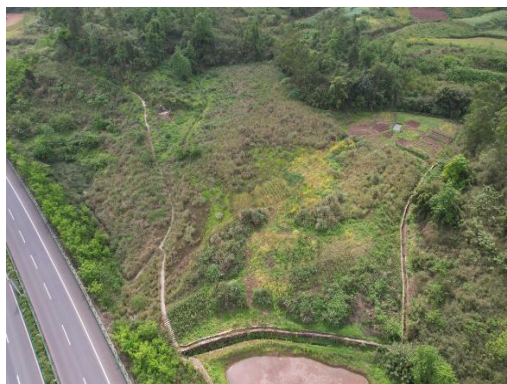
K67+300 右侧渣场现状
