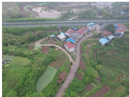
施工便道现状 2
