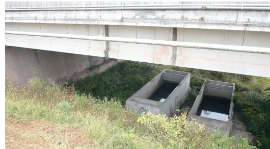
驴溪河大桥事故处理池
