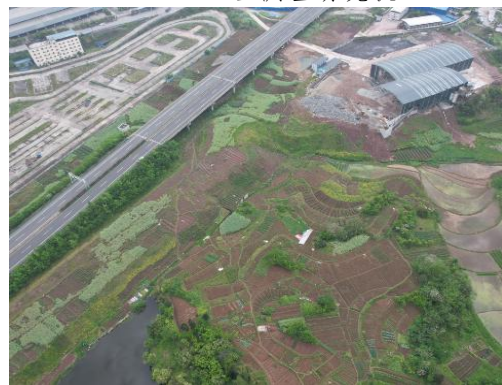
K42+500 右侧渣场现状
