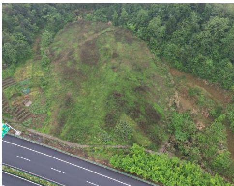
K13+600 左侧渣场现状
