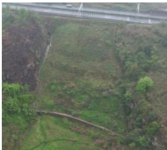
K0+820 左侧弃渣场挡墙、排水、复绿
