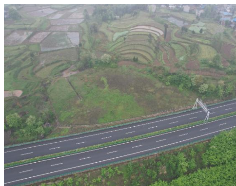
K2+650 左侧渣场现状
