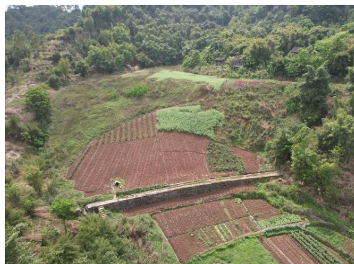
K55+600 右侧渣场现状
