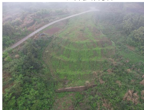
K7+150 左侧渣场现状
