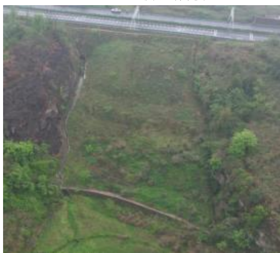
K0+820 左侧弃渣场挡墙、排水、复绿
