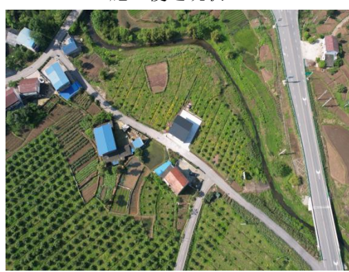
施工便道现状 4
