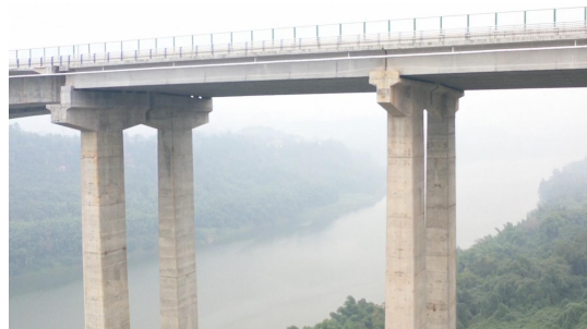
渠江特大桥径流收集
