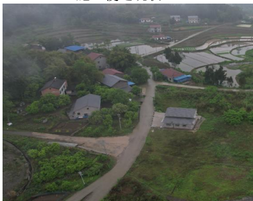
施工便道现状 3
