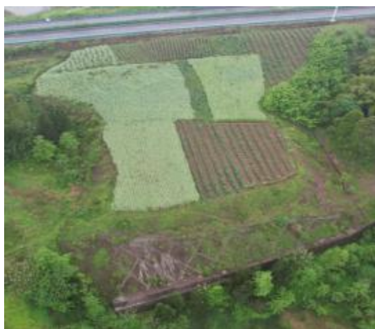
K18+460 弃渣场挡墙、排水、复耕
