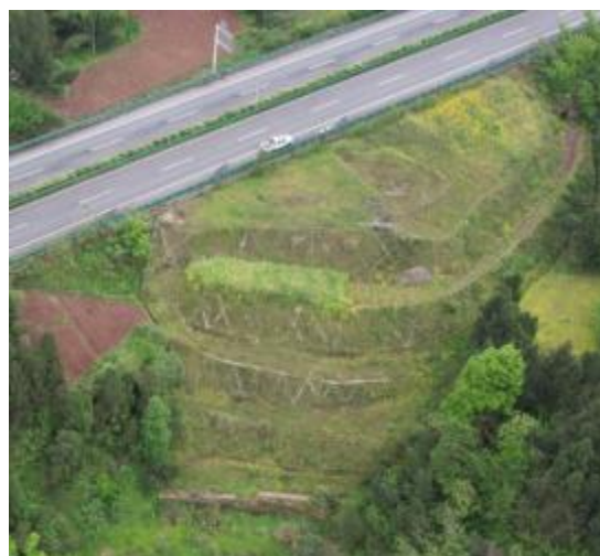
K48+200 右侧弃渣场挡墙、护坡、复绿
