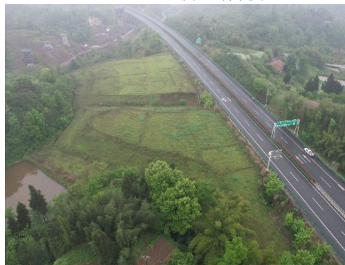
K28+500 左侧渣场现状
