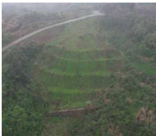
K7+150 左侧弃渣场挡墙、排水、复绿
