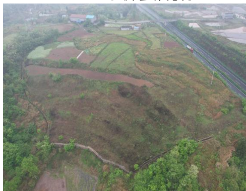
K3+800 右侧渣场现状
