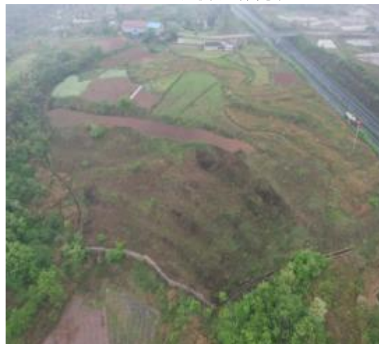
K3+800 左侧弃渣场挡墙、排水、复耕
