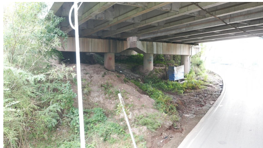
双龙河大桥事故处理池
