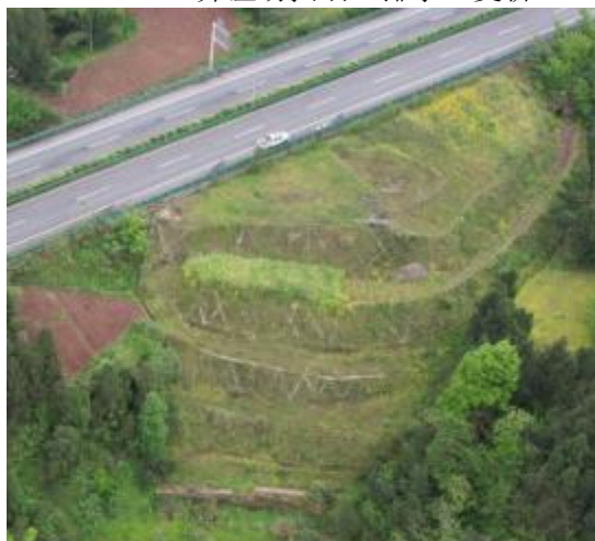
K48+200 右侧弃渣场挡墙、护坡、复绿
