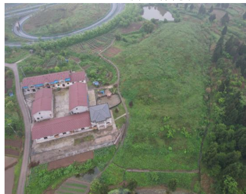
K23+680 左侧渣场现状
