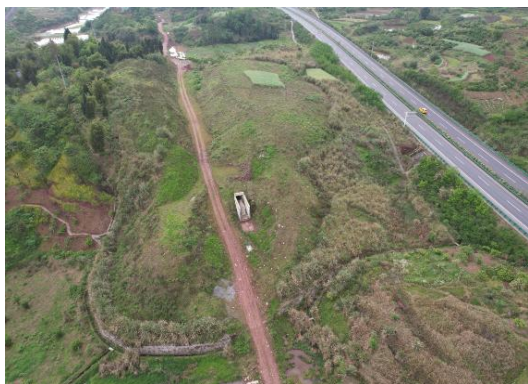
K62+160 左侧渣场现状
