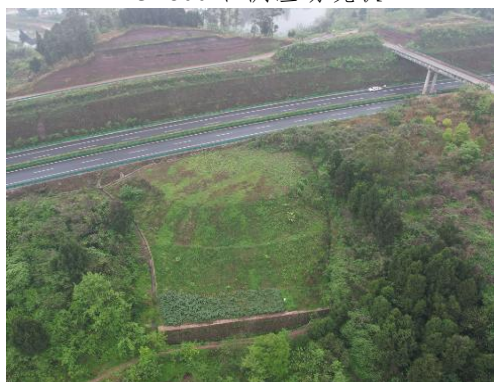
K7+400 左侧渣场现状
