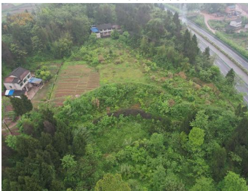
K20+700 左侧渣场现状
