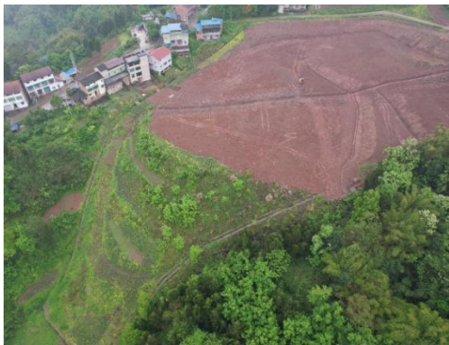
K17+000 左侧渣场现状
