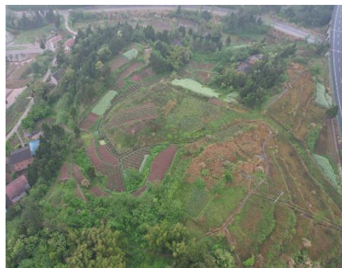
K13+860 左侧渣场现状
