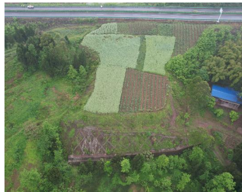
K18+460 左侧渣场现状
