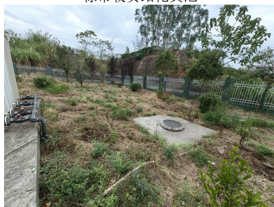
永兴收费站化粪池
