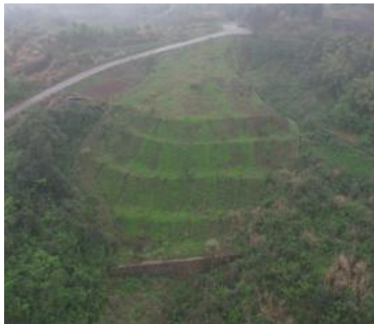
K7+150 左侧弃渣场挡墙、排水、复绿
