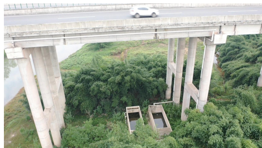
清溪河大桥径流收集
