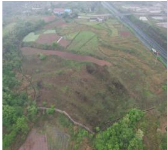
K3+800 左侧弃渣场挡墙、排水、复耕
