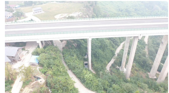
渠江特大桥事故处理池
