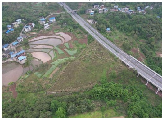
K56+280 左侧渣场现状
