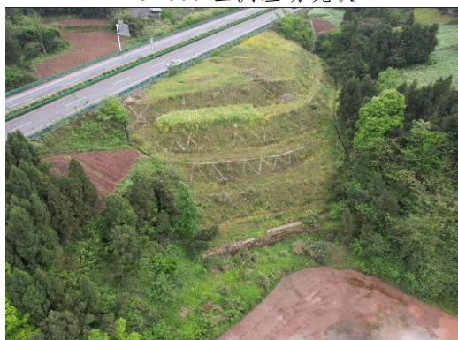
K48+200 右侧渣场现状
