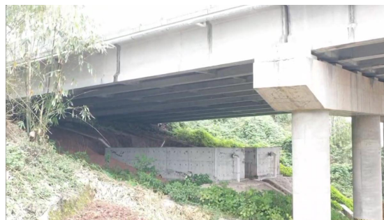
华蓥河大桥事故处理池
