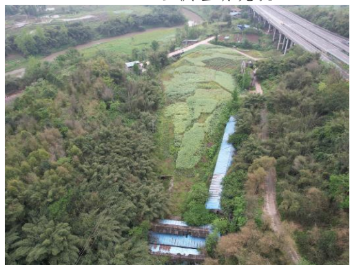
K40+100 左侧渣场现状
