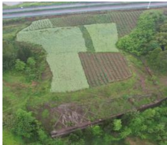
K18+460 弃渣场挡墙、排水、复耕
