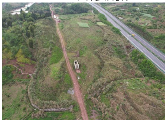
K62+160 左侧渣场现状
