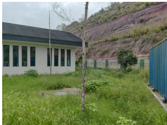
华蓥服务区化粪池
