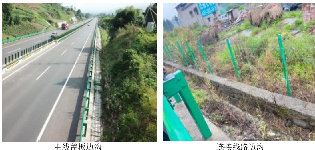
图 5.6-1 主体工程防排水照片
