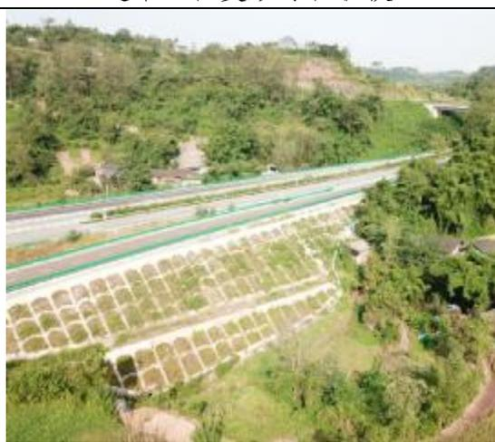
道路工程拱形骨架综合护坡
